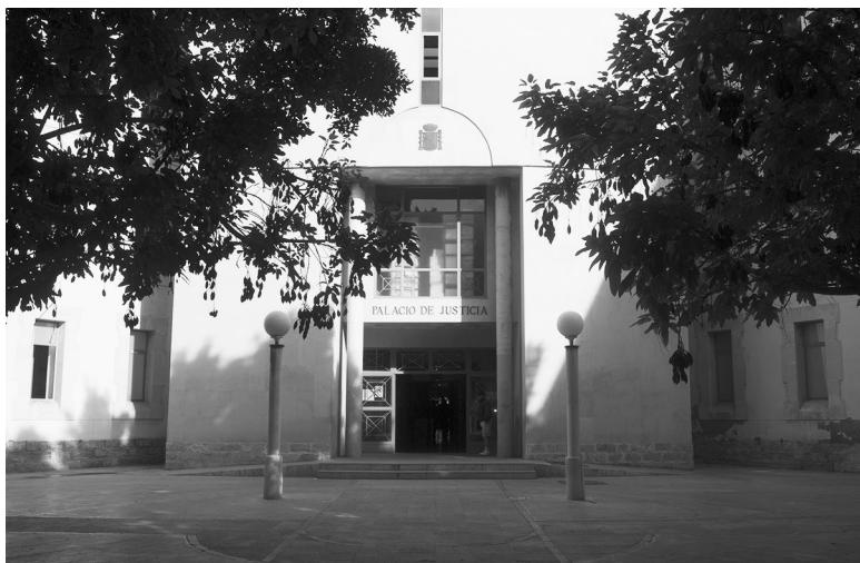
Fachada del edificio donde está la Fiscalía de Menores de Alicante.
